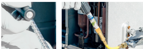
Injektion des Färbemittels durch Drehen des Griffs.
